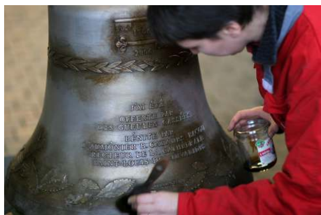
Patine et cire de la cloche « PAX » de la cathédrale des Invalides - 2006 - Photo Vincent M. ©
